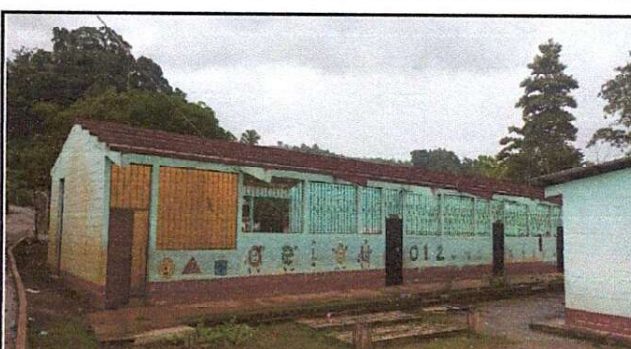
Foto 4: Pintada de costaneras del módulo
