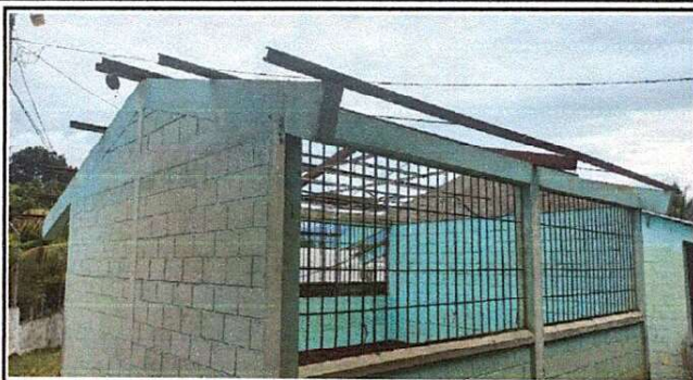
Foto 1: Desmantelamiento del techo viejo.
