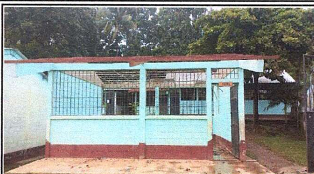
Foto 2: Desmantelamiento del aula única.
