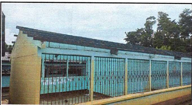
Foto 3: Limpieza y lijada de costaneras del módulo
